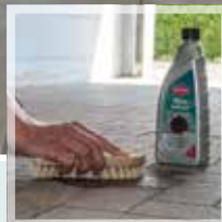
Gebundenes Öl abfegen und ggf. mit Wasser nacharbeiten.
